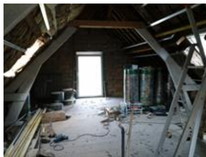
Isolation des rampants - 08/2014
