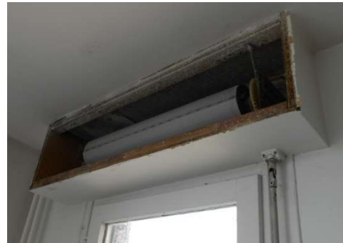
Coffre de volet en réhabilitation
