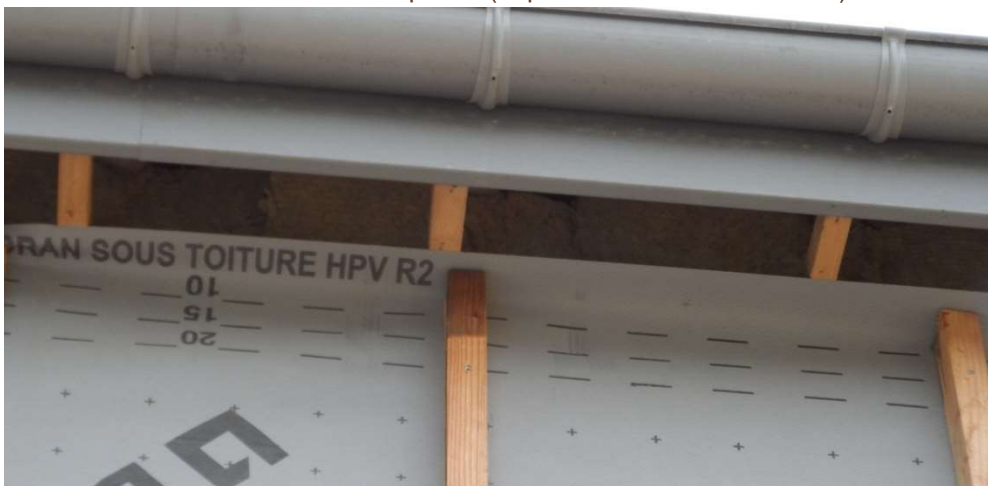
Rénovation C5-4 « MARIE PETIT » ; Photo : POUGET Consultants
