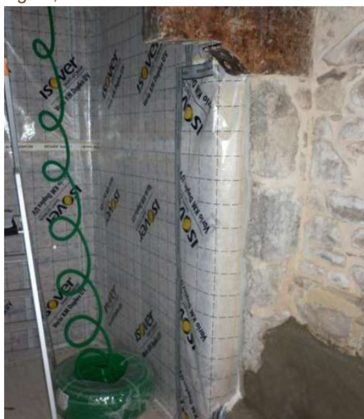
Rénovation C3-1 « LECRONIER » ; Photo : POUGET Consultants
