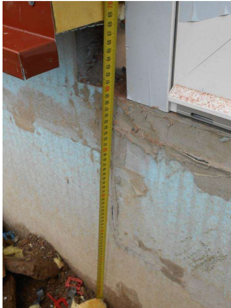
Rénovation C6-4 « COUSIN » ; Photo : POUGET Consultants
