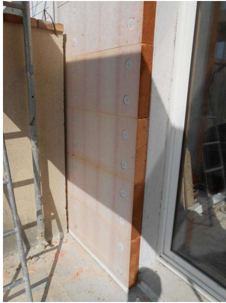
Rénovation C3-2 « VIVER » ; Photo : POUGET Consultants
