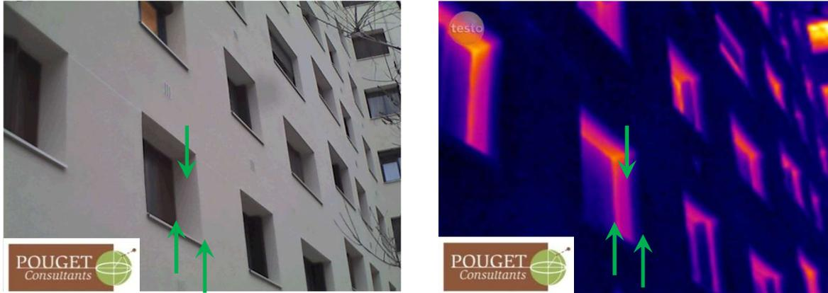
Le pont thermique (entre la flèche de gauche et celle du milieu) ainsi que l'épaisseur d'isolant rajouté (entre la flèche du milieu et celle de droite) sont bien visibles. Côté intérieur, des moisissures pourront s'y développer plus facilement.
