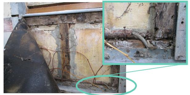
Mise à nu des pans de bois, sablière dégradée suite à mise en place d'un feutre bitumé côté extérieur et d'un polystyrène côté intérieur
