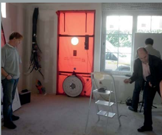
Porte soufflante lors du test d'étanchéité intermédiaire sur la rénovation C1 - 2 « HOULGATE »
